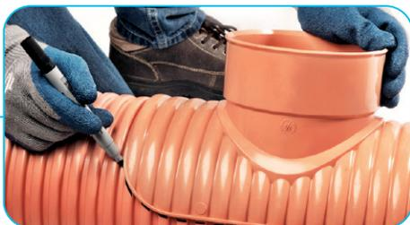
Perfore la tubería utilizando una sierra de copa de 6" o caladora. La otra opción de perforar la tubería es empleando un serrucho de punta. Cuando realice cortes, nunca golpee la superficie interior del tubo con la punta del serrucho.
